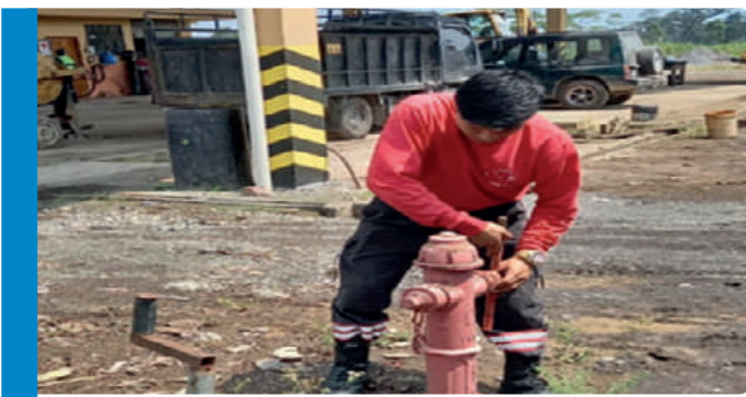
Limpieza de hidrantes.
