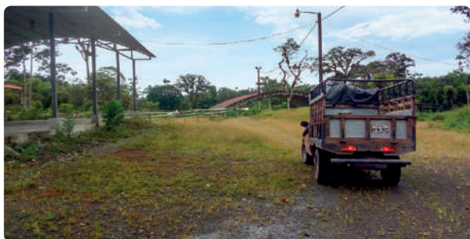
MANTENIMIENTO DE CALLES DEL RECINTO FERIAL.
