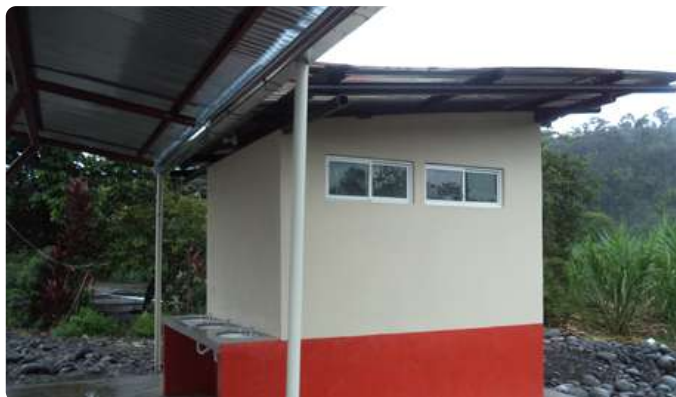
ADECENTAMIENTO DE MESÓN, PISO Y CIELO RASO DEL MINIMERCADO DE LA COMUNIDAD DE SANGAY.
