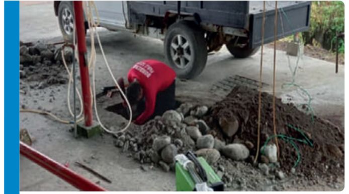
Adecuación del patio de maniobras.
