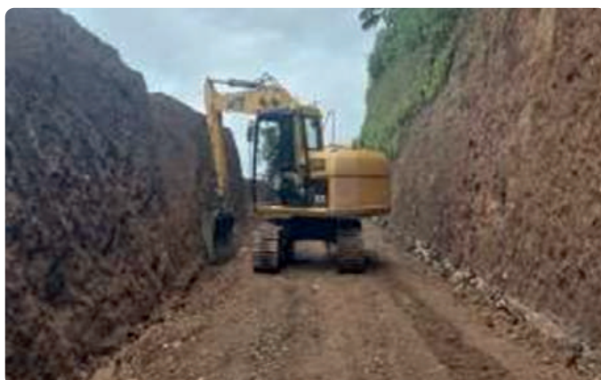
CONFORMACIÓN Y ADECUACIÓN DE LA VÍA A SANTA INÉS HACIA LAS FINCAS.
