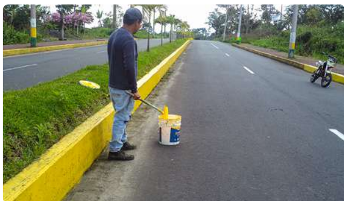
ADECUACIÓN DE PINTURA EN LOS BORDILLOS DE LAS CALLES CÉNTRICAS Y PARTERRES DEL ACCESO AL CANTÓN PABLO SEXTO.
