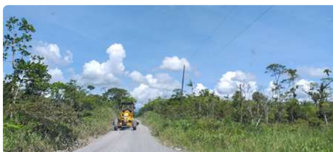
MANTENIMIENTO DE LA VÍA PABLO SEXTO-RÍO AMARILLO.
