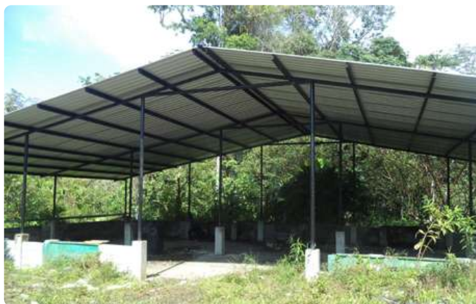
ADECUACIÓN Y MEJORAMIENTO DEL CAMBIO DE CUBIERTA DEL RELLENO SANITARIO.
