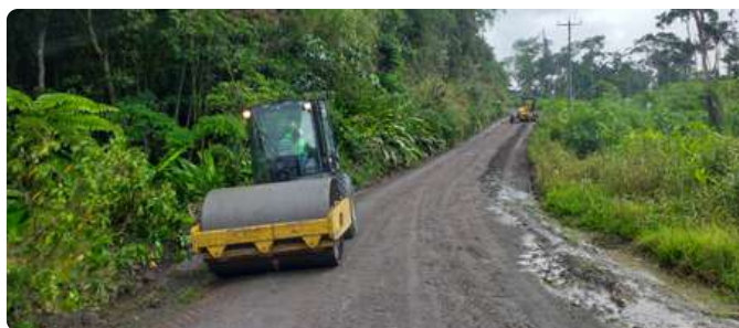
MANTENIMIENTO DE LA VÍA PABLO SEXTO-SANTA INÉS-SHAWI-KUNAMP
