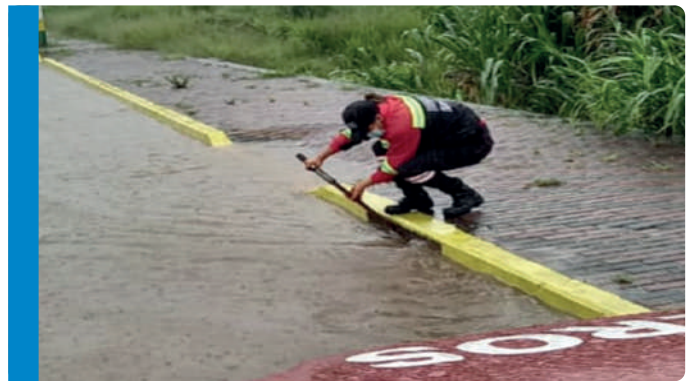
Limpieza de rejillas.
