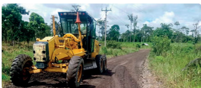
MANTENIMIENTO DE VÍA SHAWI ANTIGÜO SHAWI.
