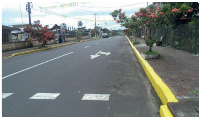
ARREGLO Y ADECUACIÓN DE MUROS Y BORDILLOS EN LA AVENIDA GUAPÁN ENTRE LAS CALLES LUIS GONZÁLEZ Y LORENZO GUILL.
