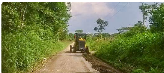
MANTENIMIENTO DE LA VÍA EL ROSARIO-TANQUES DE AGUA POTABLE.
