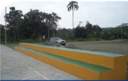
Adecuación de un graderio en la comunidad de Shawi. ₡ 3.623,94
