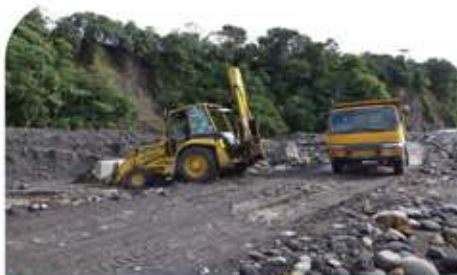
Mantenimiento de la vía Shawi - Antiguo Shawi.
