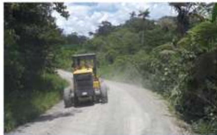
Mantenimiento de la vía Pablo Sexto - Santa Inés - Shawi - Kunamp. ₡ 65.578,04
