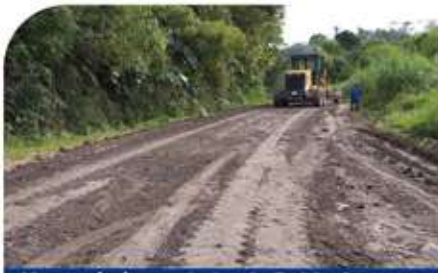
Mantenimiento de la vía Pablo Sexto - Santa Inés - Shawi - Kunamp - Puente Namakim. ₡ 87.636,11
