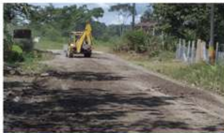
Mantenimiento de la vía Shawi - Mina Shawi 1.
