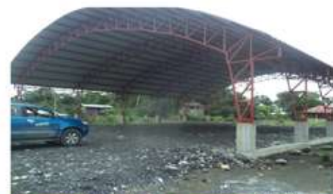
Construcción de un espacio cubierto en la comunidad Kunamp.
