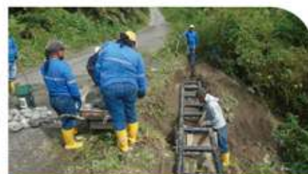
Adecuación de paso elevado de agua para las comunidades El Rosario, Kunkup y Yamanunka.
