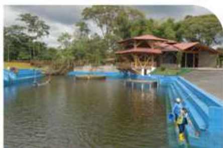
Limpieza del Dique de Pablo Sexto.
