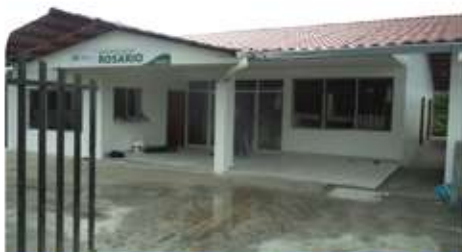
Adecuación del Centro de Salud en la comunidad de El Rosario.
