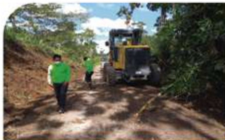
Mantenimiento de la vía Pablo Sexto - Río Amarillo. ₡ 17.887,92
