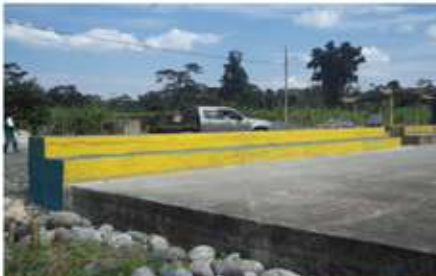
Adecuación de un graderio en la comunidad de Sangay. ₡ 3.051,77
