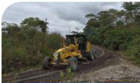
Mantenimiento de la vía El Rosario- Tanques de Agua Potable.
